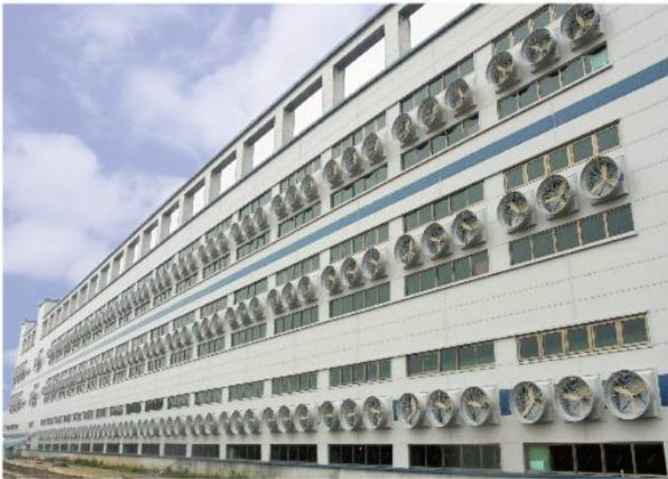
圖 1 建築物大量安裝排風扇
